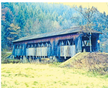
Eine aus Rottweil stammende Neckarbrücke aus Holz in Talhausen.
