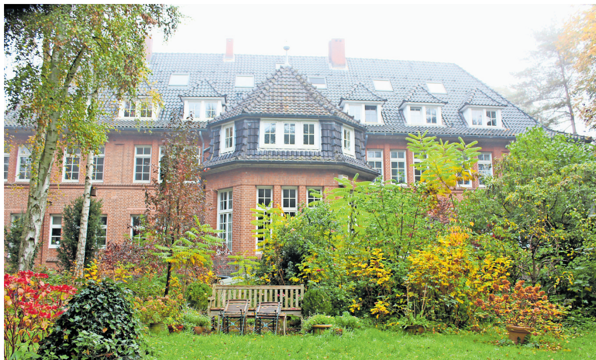
Das ehemalige Verwaltungs- und Direktorenegebäude Düneberg 185, Baugenehmigung 1912, Architekt Hermann Distel. Später Laborgebäude. Heute als Wohnhaus genutzt. (Aufnahme aus dem Jahr 2024)
