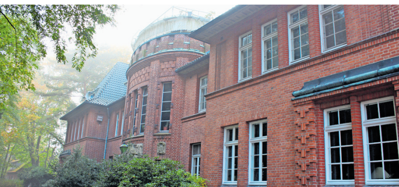
Ehemaliges Verwaltungs- und Direktorengebäude Düneberg 185. Foto: Votteler
