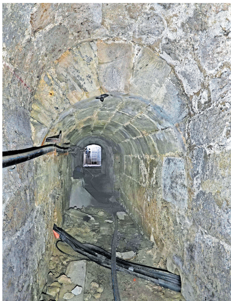
Blick in den tonnengewölbten Mauergang unterhalb der Fahrbahn mit Einstieg im Hintergrund. Im Vordergrund eine Zäsur am Übergang zum Abschnitt unterhalb des Gasthauses.
