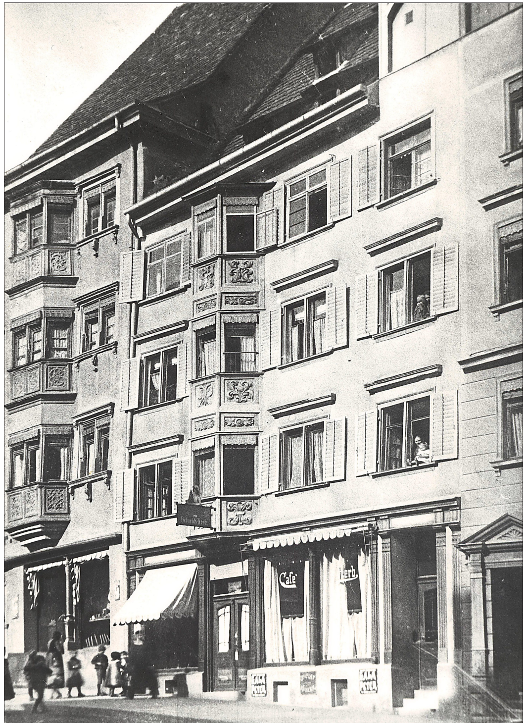
Das Rottweiler Gebäude Hauptstraße 29, das bis 1913 das beliebte „Café Herb“ beherbergte, in seiner ganzen Pracht (etwa 1910). Foto: Stadtarchiv Rottweil
