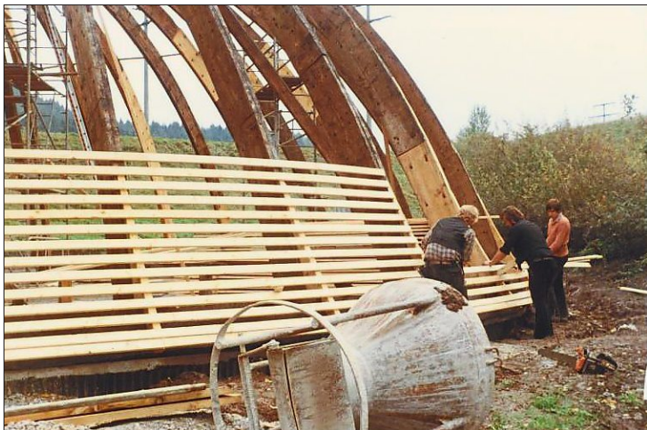
Wiederaufbau eines Solerundbehälters im Jahre 1983 auf dem Gelände des Salinenmuseums Unter Bohrhaus.
