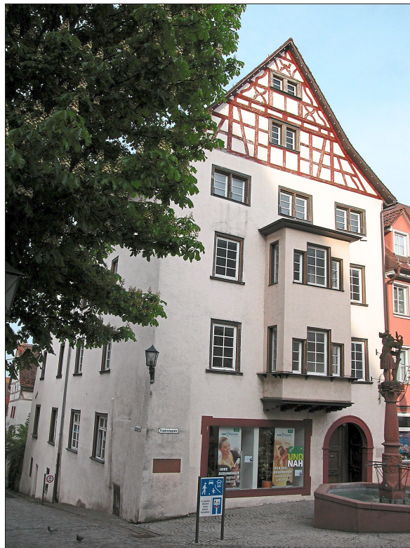
Blick auf das Gebäude Friedrichsplatz 16: Hier arbeitete die Verlagsdruckerei Rothschild von 1855 bis 1936 erfolgreich. Foto: Pfannes
