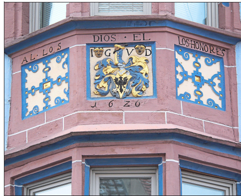
Eine besondere Note verleiht dem Rottweiler Haus Hauptstraße 58 sein 1626 aufgestockter Erker. Foto: Mager/Stadtarchiv Rottweil
