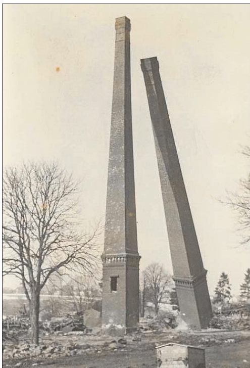
Sprengung der Schornsteine der Siedehäuser (1969) Foto: Stadtarchiv Rottweil
